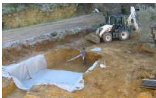
Fouille d'un filtre à sable
