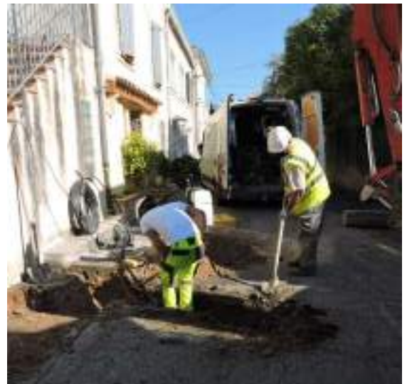
Renouvellement d'un branchement
