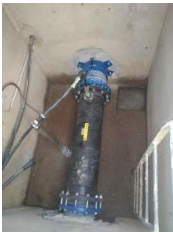
Figure 3 : Pose du mélangeur statique pour PAX, Fontcouverte
