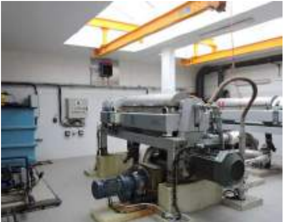
Centrifugeuse à boues
