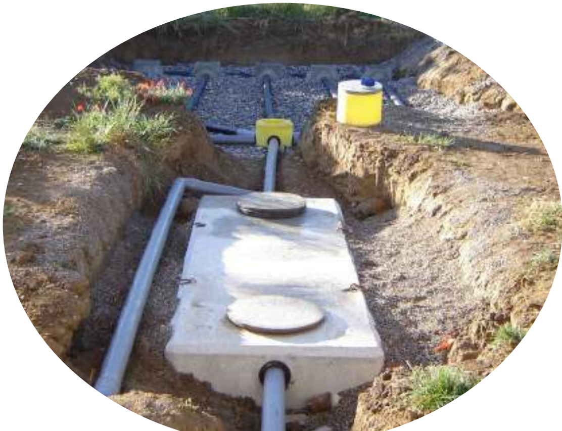
Fosse et filtre à sable non drainé
