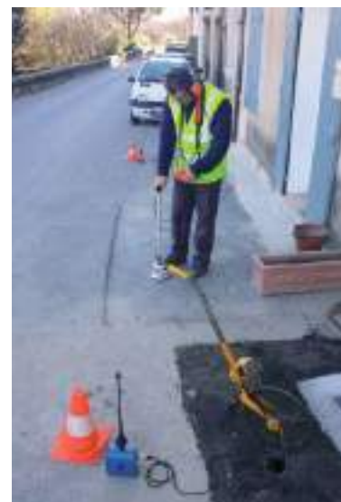
Repérage de fuite par écoute acoustique
