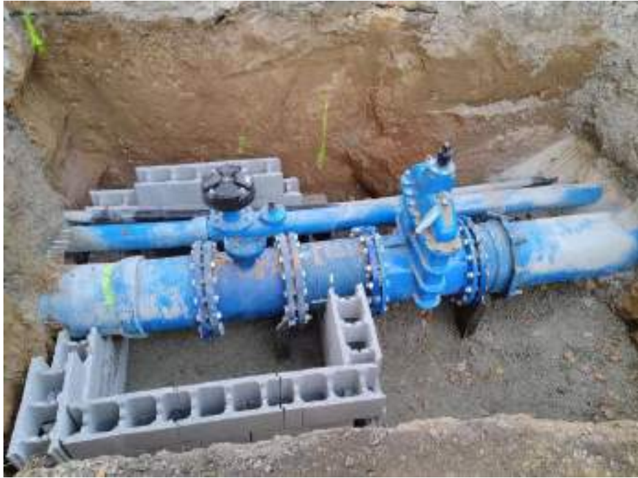
Figure 7 : Regard ventouse Valabre
