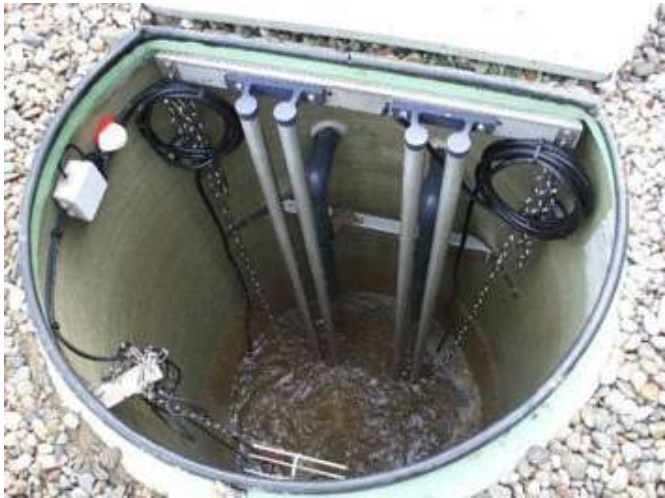
Opération d'entretien sur un poste de relevage
