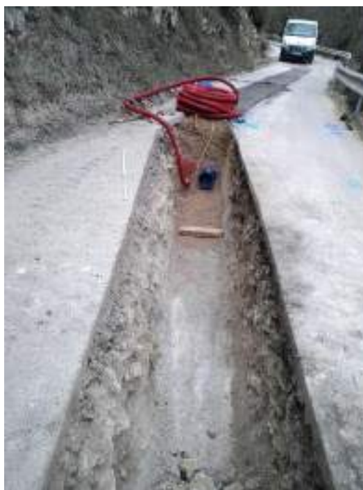
Figure 5 : Chantier Fontcuberte, Venelles
