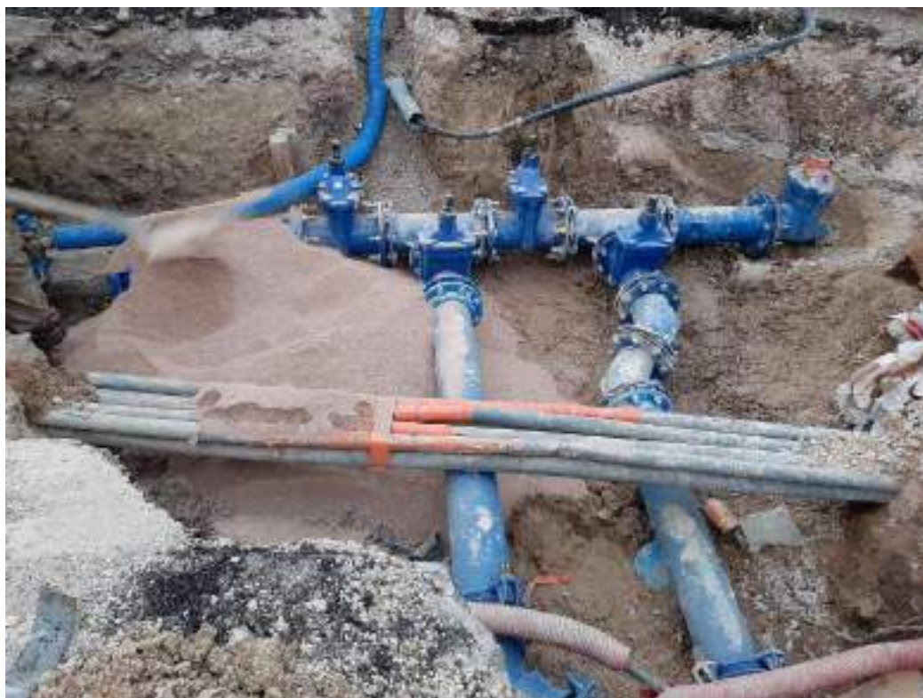
Figure 9: Chantier de la Resquillette, Venelles
