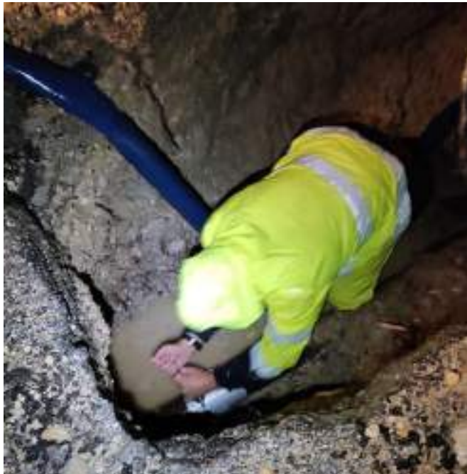
Réparation d'une fuite sur le réseau
